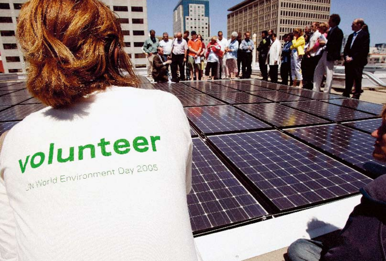
Un groupe de visiteurs photographiés le 4 juin 2005 près des panneaux solaires du sommet du Centre de Moscone, à San Francisco (Californie). Ces panneaux d'une puissance maximum de 675 kilowatts peuvent fournir 20 à 30 % de l'électricité d'une convention se tenant dans le Centre. Il s'agit, dit-on, de l'un des plus grands systèmes municipaux de production d'énergie solaire aux Etats-Unis. San Francisco a accueilli les manifestations de la Journée mondiale de l'environnement de 2005 sur le thème « Des villes vertes ». © David Paul Morris/Getty Images
