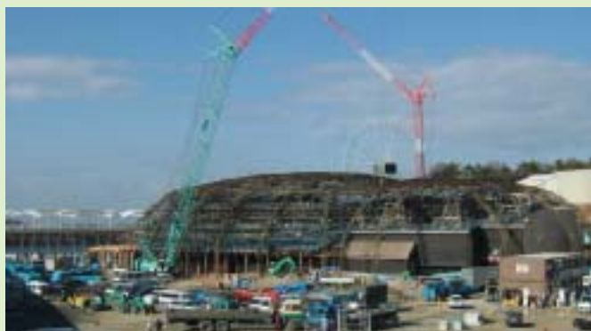
Pavillon japonais en construction.
