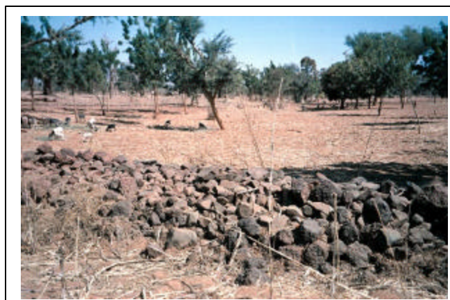
La technique des digues filtrantes
