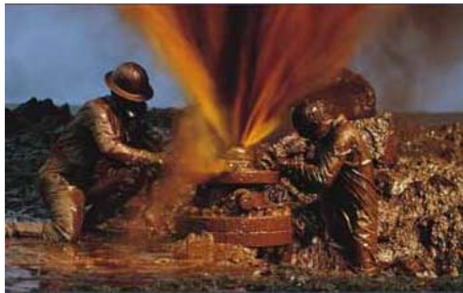
Tapando un pozo de petróleo, Kuwait © S. Compoin / PNUMA / Still Pictures
