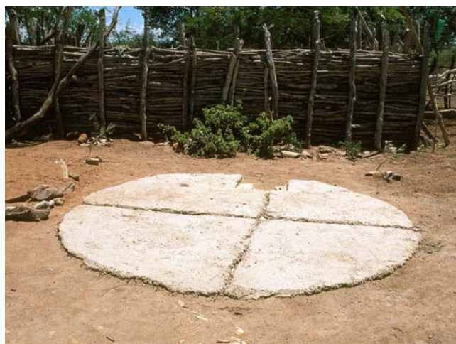
Illustration 14: Construction de réservoirs d'eau de pluie
