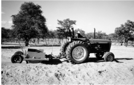
Illustration 18: Travail de la terre pour la construction du barrage
